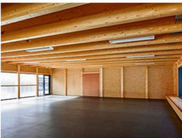
Die Trainingskalthalle zeigt eine kostengünstige Möglichkeit einfach elementierter Ingenieurholzkonstruktion für stützenfreie Hallen.
