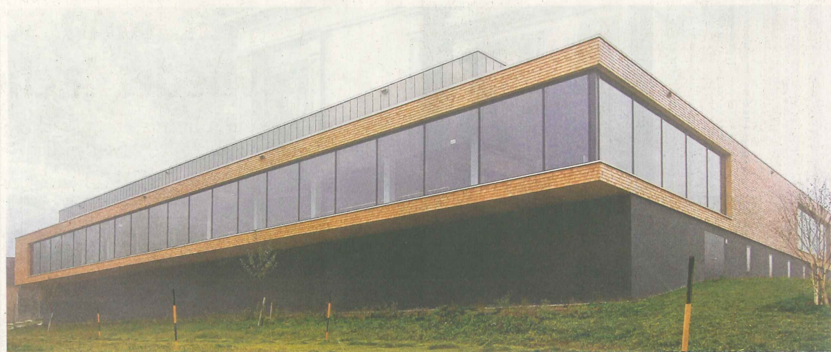
Panoramafenster, klare Linien, ein wenig auffälliges, innovatives Dach und gut eingepasst in die Umgebung: Die „Panoramarena“ in Wiggensbach besticht durch ein ausgeklügeltes architektonisches Konzept. Damit könnte sie Vorbild sein für andere Sporthallen im Allgäu. Foto: Ralf Lienert
