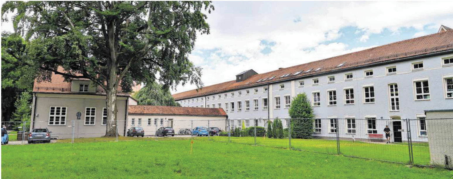
Auf dieser Freifläche soll die neue Sporthalle für die Reichshainschule in Memmingen errichtet werden. Foto: Uwe Hirt
