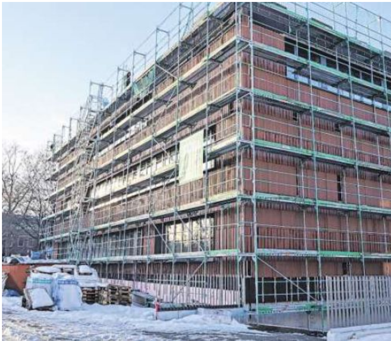
Die Kosten für die Sanierung und Erweiterung des Beruflichen Schulzentrums liegen insgesamt bei 103 Millionen Euro.
