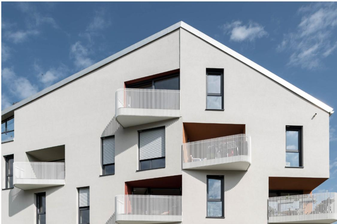
Eine wärmebrückenfreie Gebäudehülle aus ThermoPlan-Ziegeln in der Stärke 42,5 und dreifach isolierverglaste Fenster ergeben zusammen mit einfacher, robuster Technik eine nachhaltige Bausubstanz. Foto: f64 Architekten
