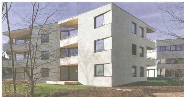
Mehrfamilienhaus am Stadtpark in Memmingen
