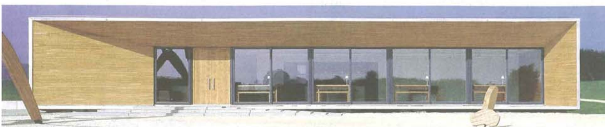
Die „Hausschneiderei“ der Firma Baufritz in Erkheim
