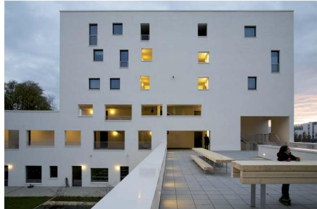
Auch „Jules et Jim“ ist in monolithischer Ziegelbauweise errichtet worden - mit Planziegeln mit einer Wanddicke von 42,5 cm. Hier tragen die unregelmäßig verteilten Fenster mit ihren verschiedenen Größen und die Loggien zu einem lebhaften Bild bei, das durch einen etwas raueren Putz noch zusätzlich unterstrichen wird.
