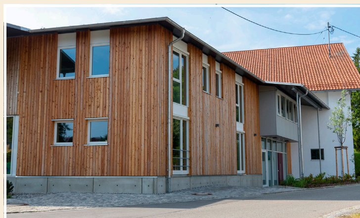
Nach rund 2-jähriger Bauzeit erstrahlt die neue Kindertagesstätte „Pusteblume“ in neuem Glanze. Foto: Dürr
