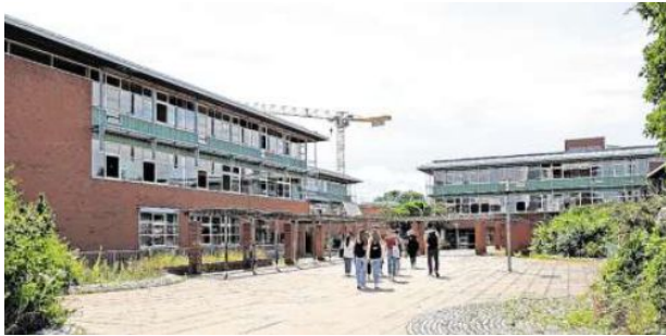
So präsentiert sich der Campus aktuell. Der Kran im Hintergrund bedient die Baustelle von Fach- und Berufsoberschule. Foto: Martina Diemand
