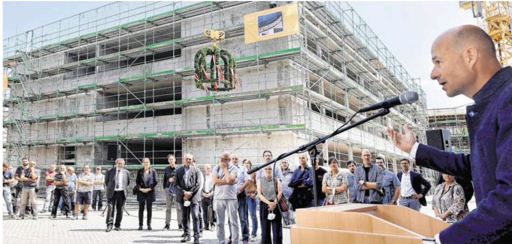
Mit Baubeteiligten, Schulleitern und Verbandsräten des Zweckverbands Berufliches Schulzentrum freute sich am Montag Kemptens Oberbürgermeister Thomas Kiechle über das Richtfest für die Erweiterung von FOS und BOS. Im September 2022 soll das Gebäude Schülerinnen und Schülern den lang ersehnten Platz bieten. Foto: Martina Diemand
