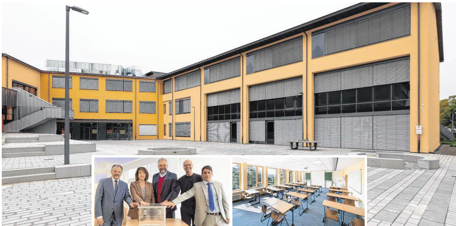
15 Millionen Euro investierte der Landkreis Ostallgäu als Sachaufwandsträger in die Sanierung und Erweiterung der Realschule Obergünzburg. Neben der energetischen Sanierung wurden auch die Klassenzimmer saniert und es entstanden helle Unterrichtsräume. Bei der offiziellen Eröffnung wurde auch ein Zeittresor befüllt. Fotos: Peter Roth, Dirk Ambrosch, F64 Architekten
