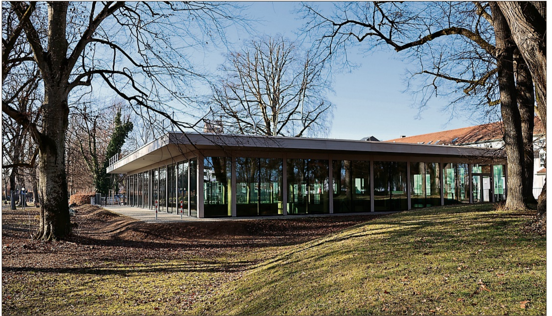
Der oberirdische Baukörper besteht aus einem Holztragwerk mit Glasfassade.
