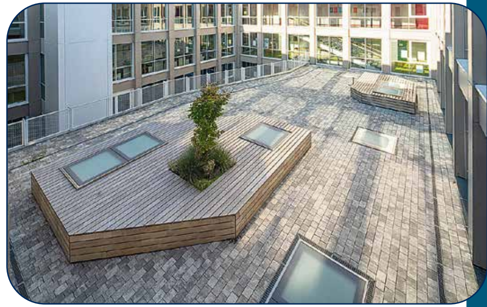
Blick in den Innenhof. Ein Teil wurde überbaut. Das Dach wird als Lese-Terrasse für die Bibliothek genutzt. Fotos: Joern Blohm / F64 Architekten
