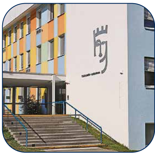
Die Fassade – hier am Haupteingang – wurde neu gestrichen. Foto: Matthias Becker
